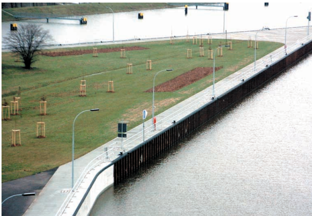
Kippmaste BM2060, auf der Schleusenanlage Rothensee Wasserstraßenkreuz Magdeburg
